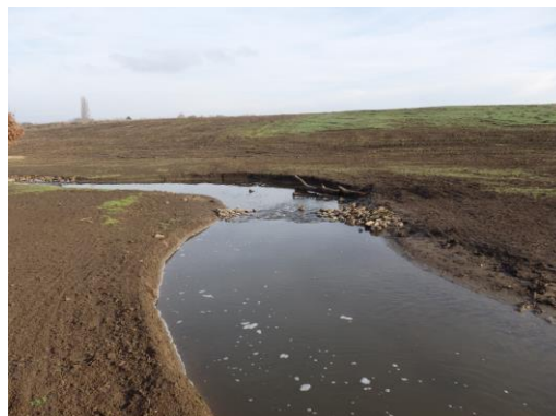
Obr. Doplnění přechodových úseků formou kamenného zához zatlačovaného do dna – nastavení hladiny v toku
