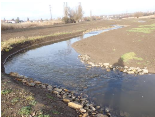
Obr. Doplnění přechodových úseků formou kamenného zához zatlačovaného do dna – nastavení hladiny v toku
