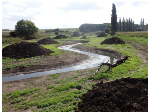
Obr. Zprůtočnění koryta bez přechodových úseků
